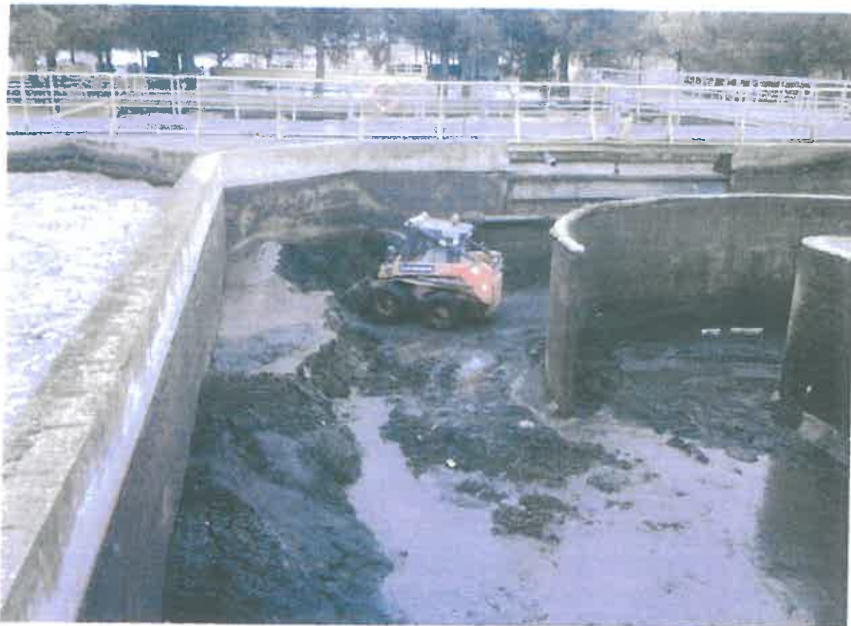
Foto n. 10 - Vasca di ossidazione del Depuratore di Pescara. Pulizia.
