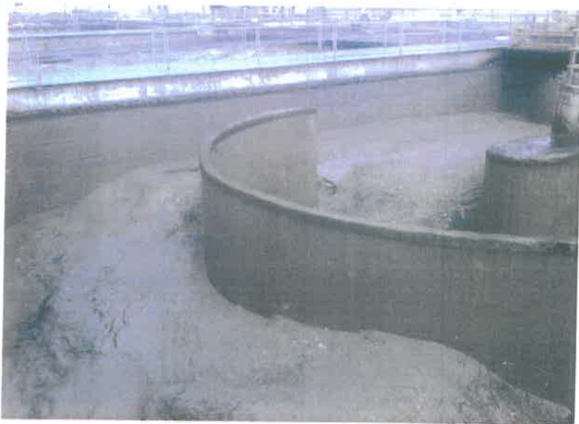
Foto n. 9 - Vasca di ossidazione del Depuratore di Pescara. Prima della pulizia.
