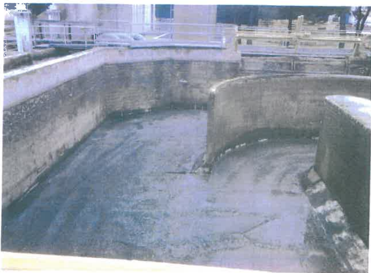
Foto n. 11 - Vasca di ossidazione del Depuratore di Pescara. Pulizia effettuata.
