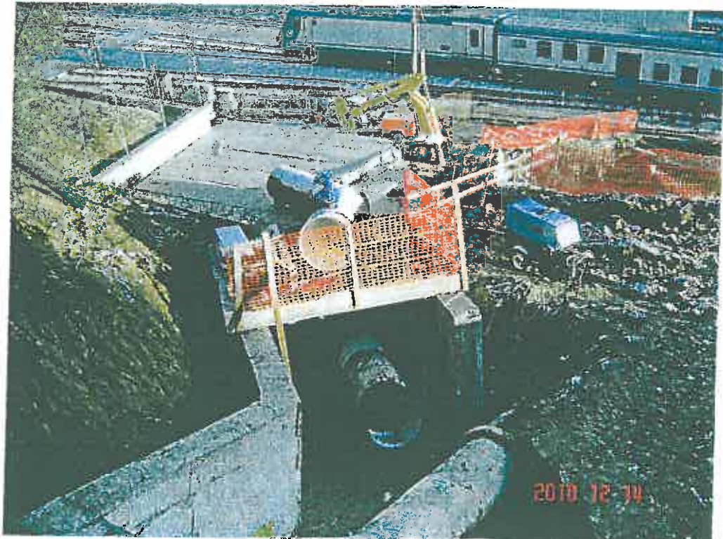
FOTO 1 – Intervento Via Canova a monte
