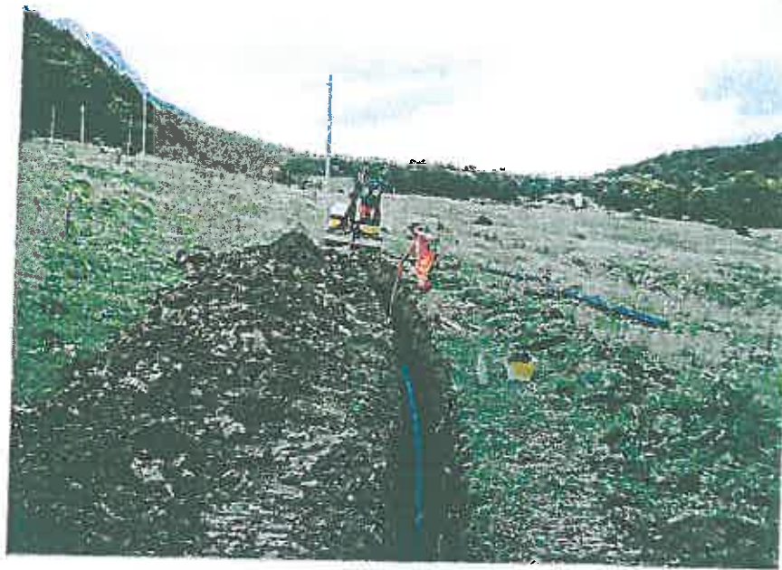
Realizzazione rete fognaria moduli abitativi post sisma Arsita
