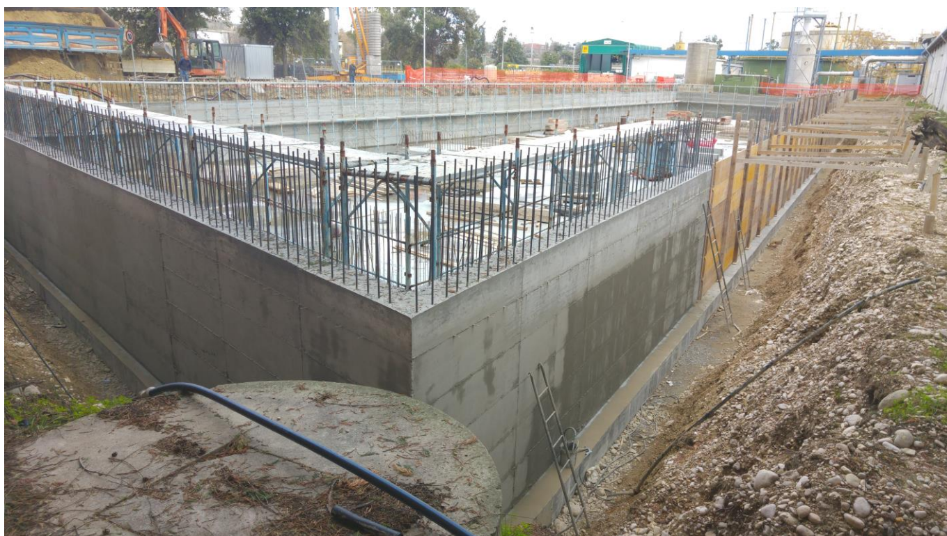
DEPURATORE MONTESILVANO – PE
