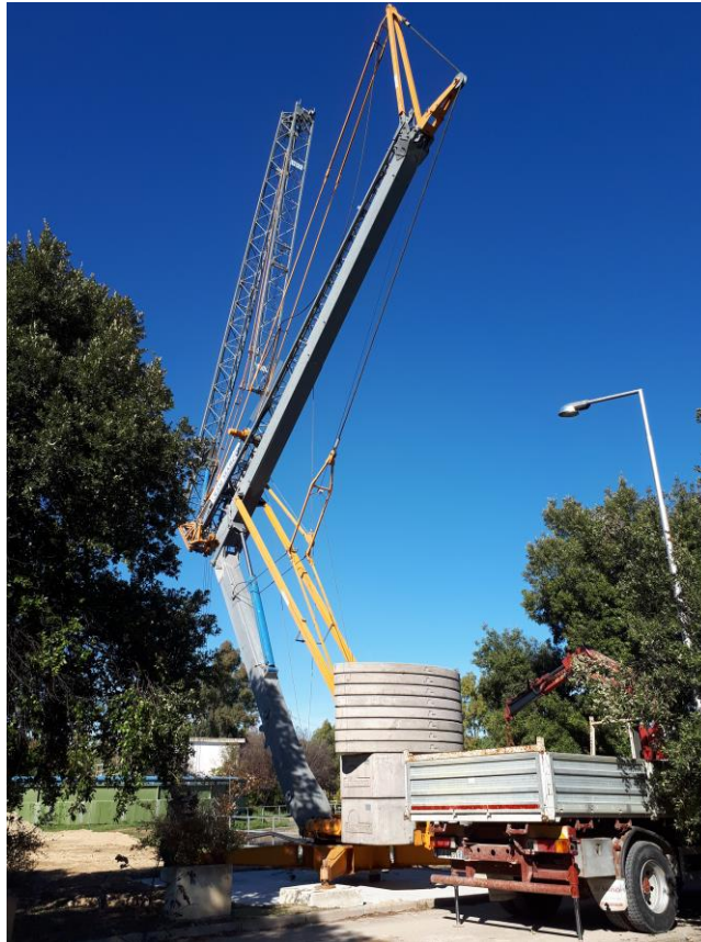
DEPURATORE MONTESILVANO – PE
