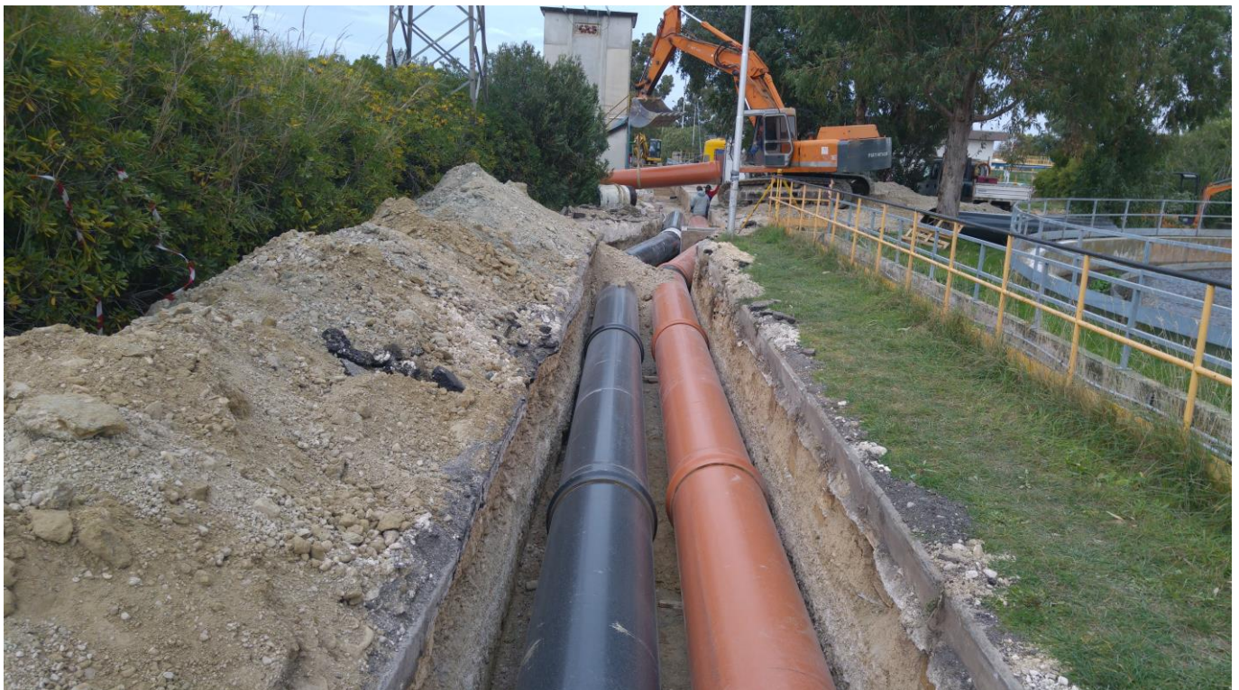
DEPURATORE MONTESILVANO – PE
