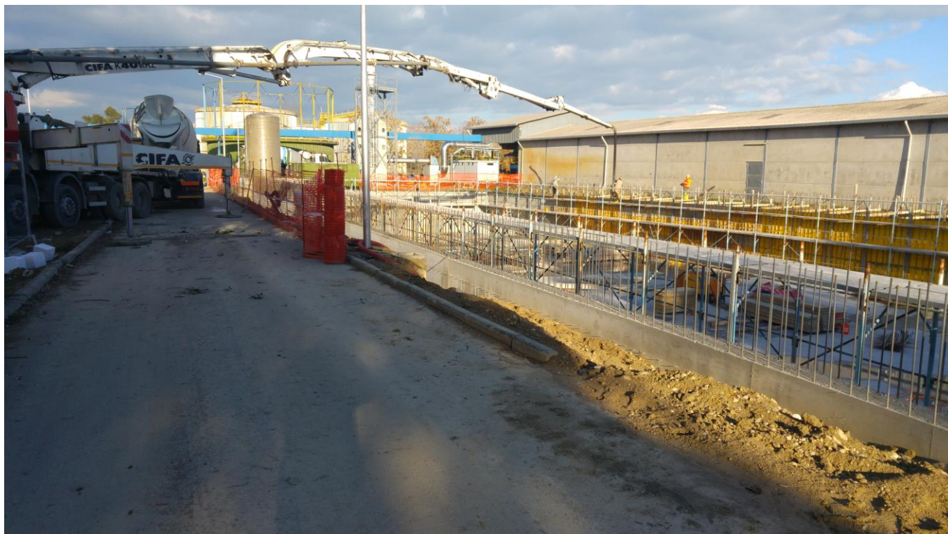
DEPURATORE MONTESILVANO – PE
