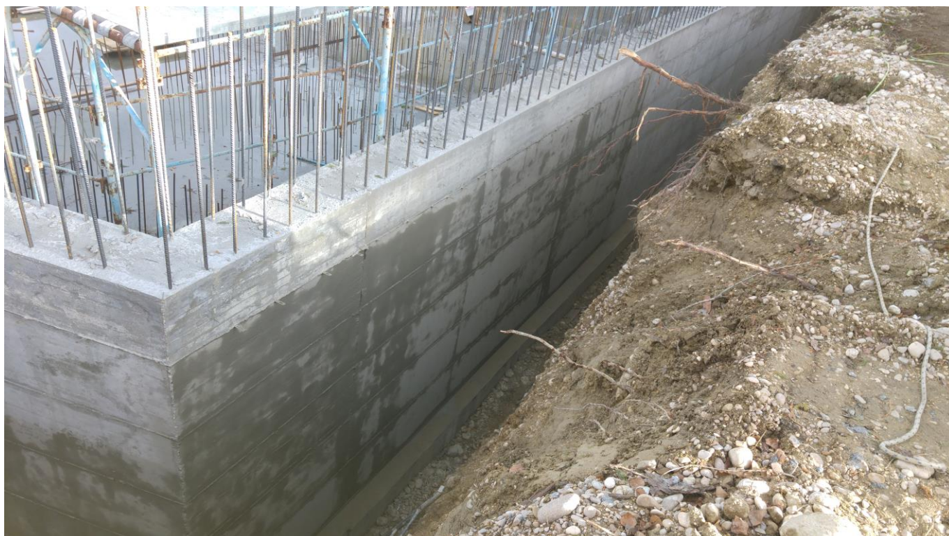
DEPURATORE MONTESILVANO – PE
