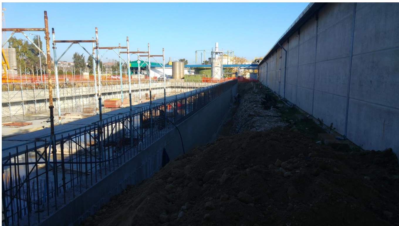
DEPURATORE MONTESILVANO – PE
