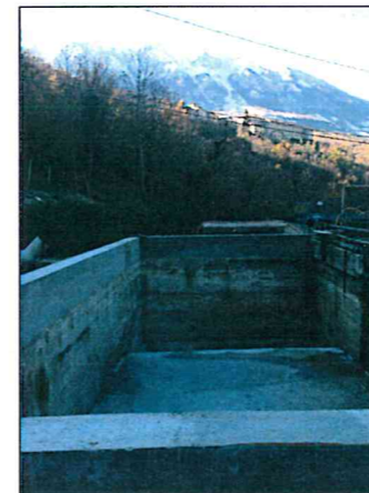
F.3: Vasca di sedimentazione
