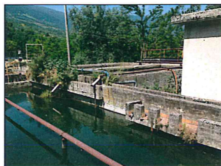
F.6: Vasca di degestione aerobica fanghi
