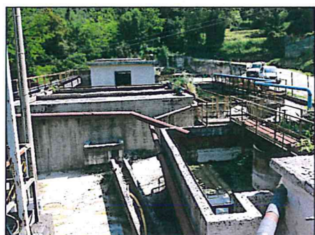
F.4: Vista vasca di sedimentazione pluviali e vasca di ossidazione
