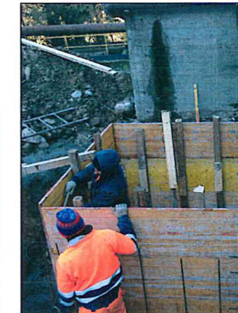
F.4: Pozzetto di ricircolo fanghi
