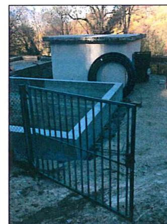
F.6: Locale quadri e soffianti
