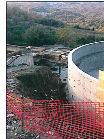
F.3: Vasca di sedimentazione
