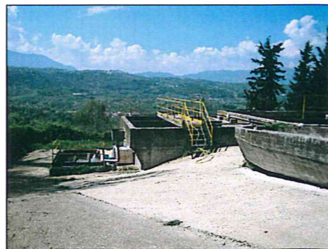
F.6: Sedimentatore - bacino di disinfezione
