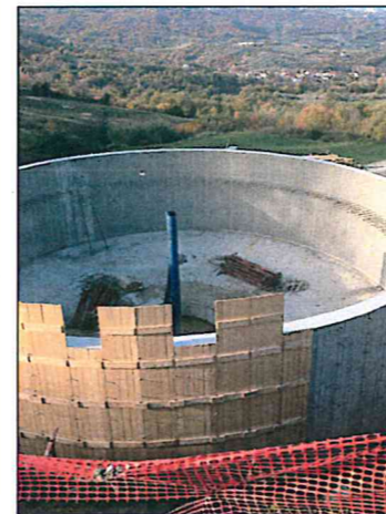
F.1: Vasca di sedimentazione
