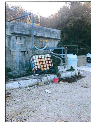
F.6: Ex vasca di sedimentazione
